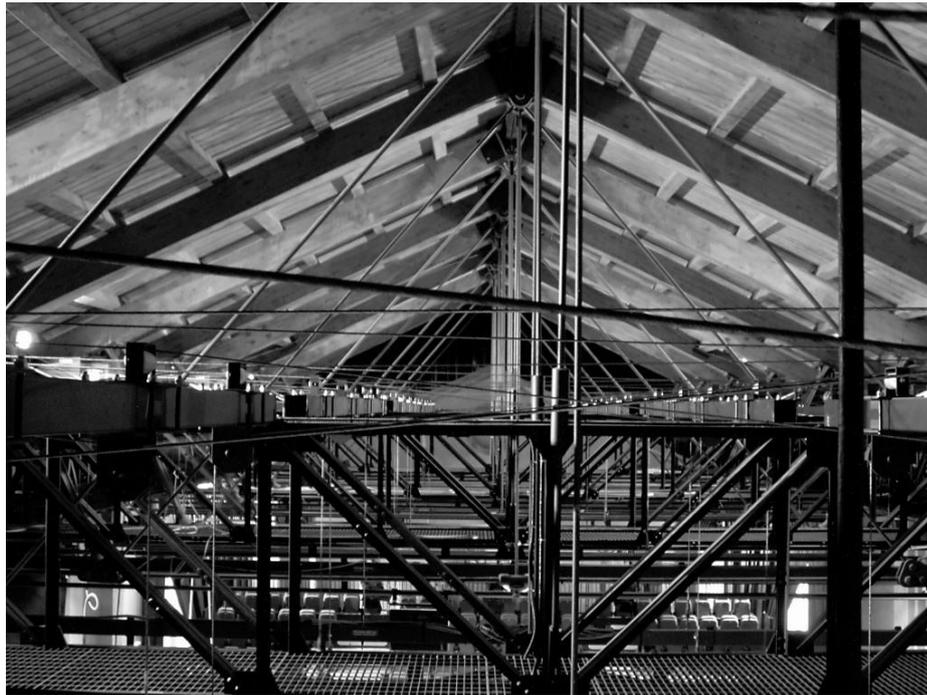
Il teatro non è dotato di una vera e propria graticcia, ma di una struttura a passerelle metalliche, provvista di n.16 tiri motorizzati fissi, con portata di 400kg a carico distribuito.
