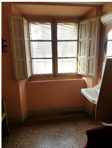
Serramento in legno e vetro singolo
