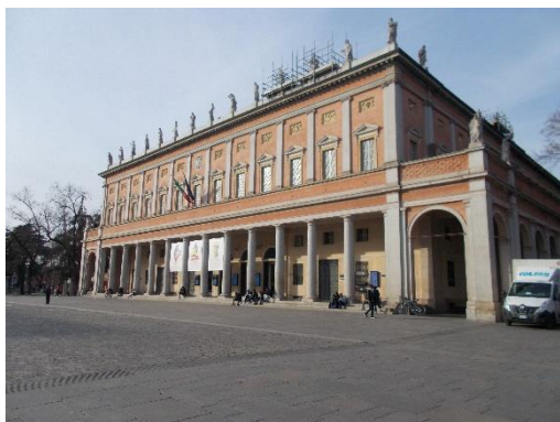
Vista facciata principale
